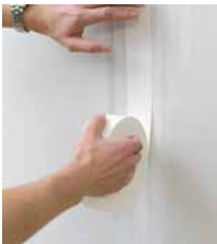
Vid spackling av skarvar mellan gipsskivor förstärk med en pappers- eller glasfiberremsa som sedan överspacklas med Casco Spack LF 3571, Casco Spack LM 3574 eller GipsFiller 3679.
