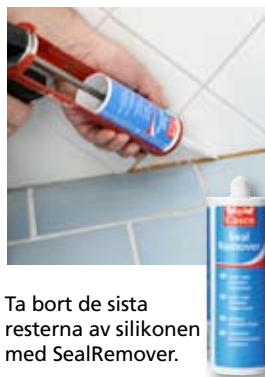
Foga med Casco Våtrumsfog. Spraya med vatten.
