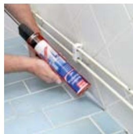
Foga med Casco Våtrumsfog. Spraya med vatten.
