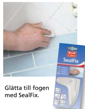
Foga med Casco Våtrumsfog. Spraya med vatten.
