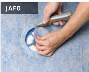
Skär ut hålet i WetStop folie/brunnsmanschetten, följ skärmallens insida.
