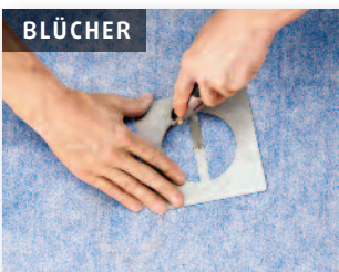
Placera den cirkelrunda skärmallen på skruven. Skär ut och markera tapphålen.
