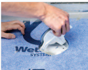
Gör uttag av hålet och ta upp Purusknivens fot ur brunnen.
