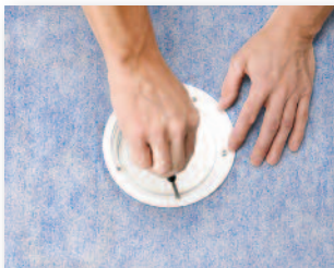
Skruva fast för hand
