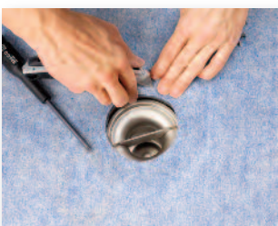
Klipp eller skär ut för tapphålen. Tryck tapparna igenom WetStop folie/brunnsmanschett.
