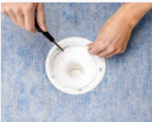
Passa in avsedda skruvar till skruvhålen i brunnen.
