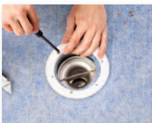
Skruva fast klämringen enligt Blüchers monteringsanvisning.
